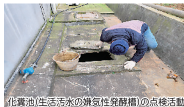
化粪池(生活污水の嫌気性発酵槽)の点検活動
